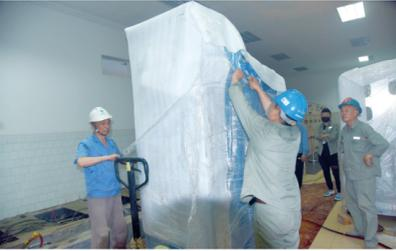
郢都水厂高低压配电系统改造工程是今年集团公司的重点项目之一，为确保改造期间水厂持续运行不停产，郢都水厂和施工单位经过周密的计划，于5月20日正式开工，5月27日完成设备安装任务。此次改造工程总造价为149万元，由中南设计院设计，荆州市强宏电气安装公司负责设备安装。改造工程主要包括：拆除原21台套高压配电柜和16台套低压配电柜，并安装19台KYN28-12型10KV高压柜和16台套低压配电柜，同时增加一组50KW发电机组，并在高压配电柜内设置微机综合保护装置与智能除湿装置，以及全厂低压负荷重新整合。
