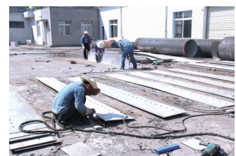
柳林水厂沉淀池工艺设备进行整体更换。
