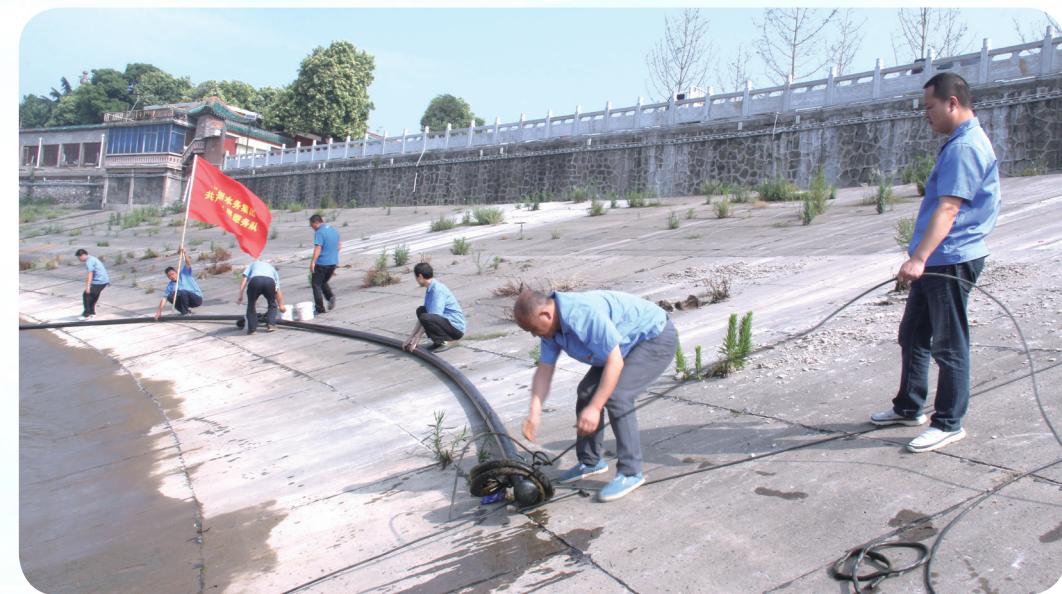
风雨中，“一米线”受损严重，荆州水务集团管网抢修员及时进行了修复和加固。
