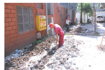
十方庵社区水改工程。
