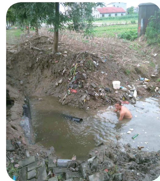
积水中，荆州水务集团管网抢修员冒雨在臭水坑中修复漏点40余处，保障居民用水。
