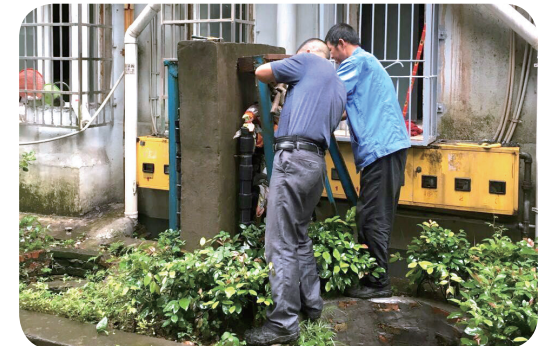
小区中，荆州水务集团维修人员不间断巡查供水设备，及时修复，安全、优质供好水。
