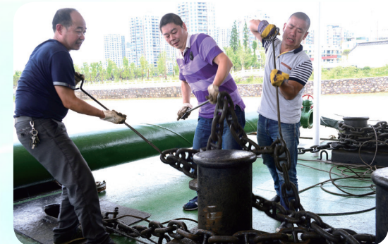
长江上，水位急剧上涨，荆州水务集团取水泵船巡查员24小时不间断观测水位变化，对泵船锚链进行及时收放，确保取水安全。
