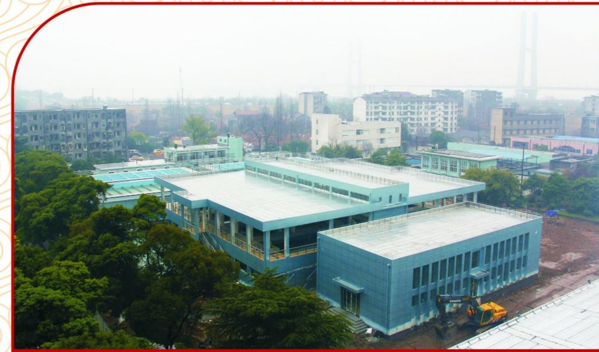
南湖水厂一期工艺全面改造。
