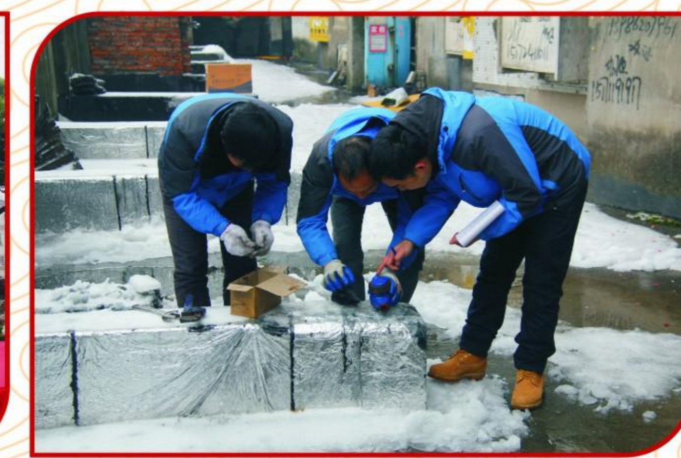
冰冻天气，为居民更换冻裂水表。
