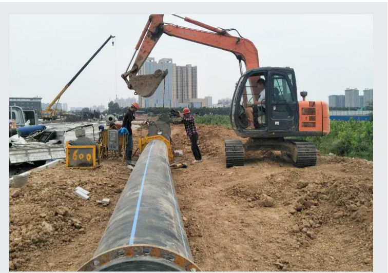
近日，楚都大道（楚源大道——凤凰路）DN1000mm管网建设工程进入分段施工阶段。
